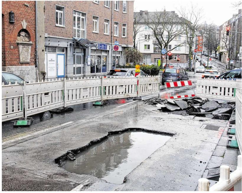
Und dann war die Fahrbahn weg: An der Minoritenstraße hat sich wegen eines Wasserrohrbruchs ein großes Loch aufgetan. Das Rohr ist mittlerweile repariert, bei der Fahrbahn dauert das aber noch bis Anfang der Woche. An dem Nadelöhr drohen nun lange Staus.
